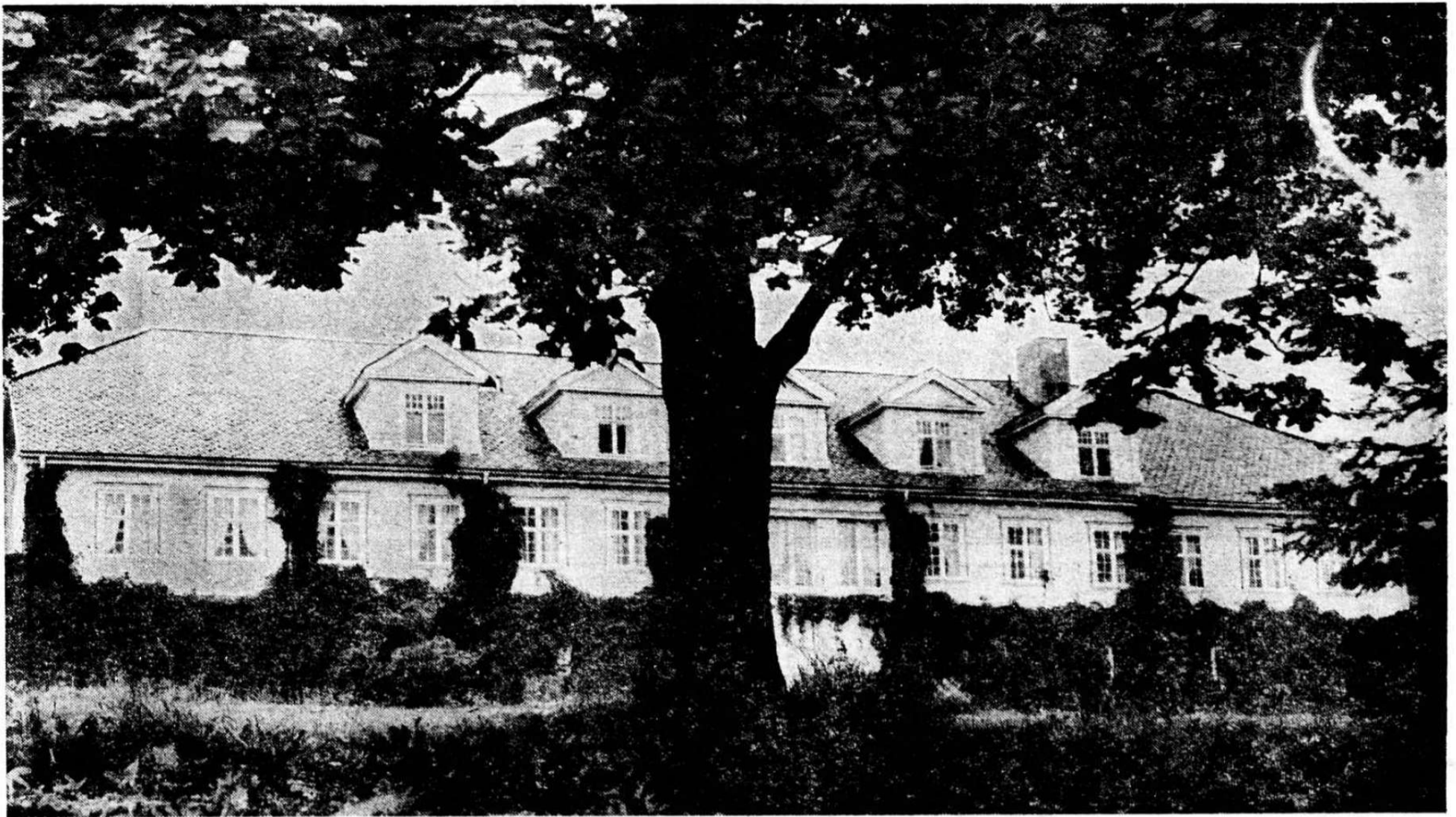
Grefsheim sett fra havsiden.
